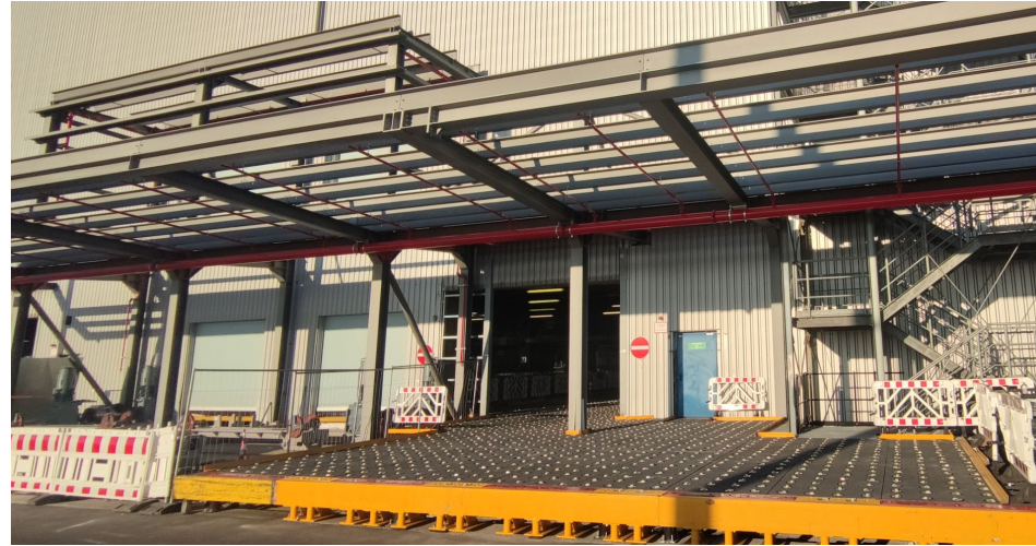
UPS-Logistikzentrum am Flughafen Köln/Bonn
