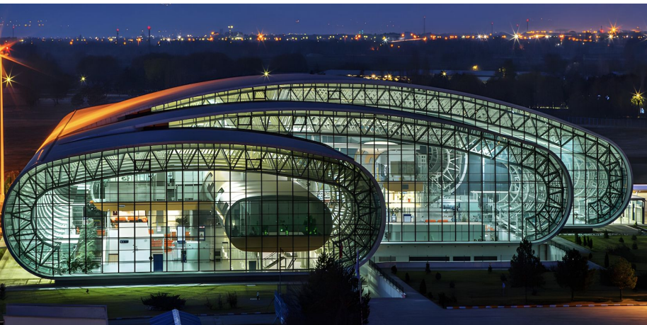
Flughafen Erzincan, 2.600 tons
