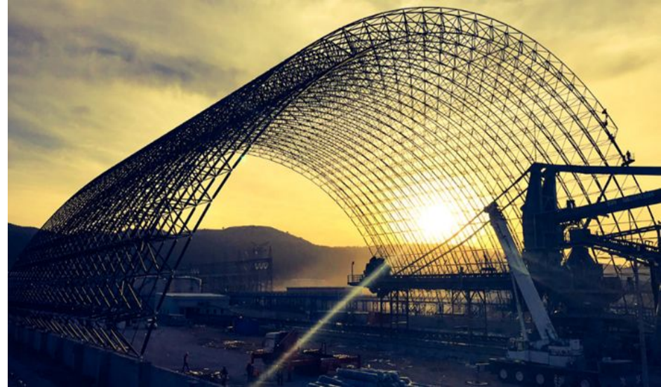
Waermekraftwerk Soma in Soma, Türkei, 16.000 m 2
