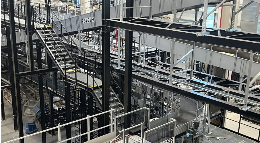
UPS-Logistikzentrum Langenhagen in Hannover
